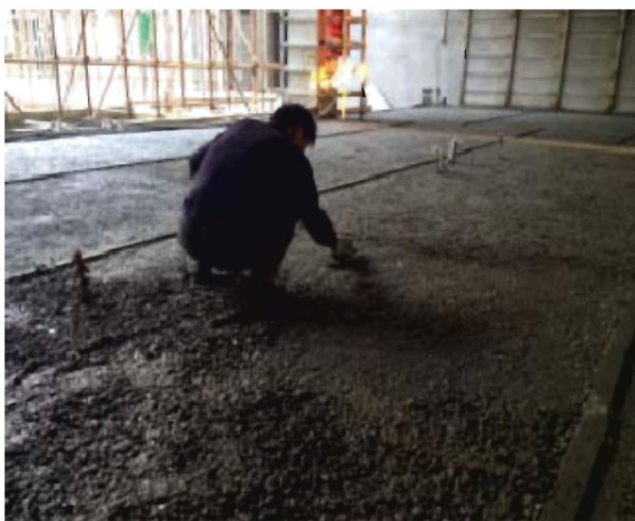
A型轻质垫层地面施工
