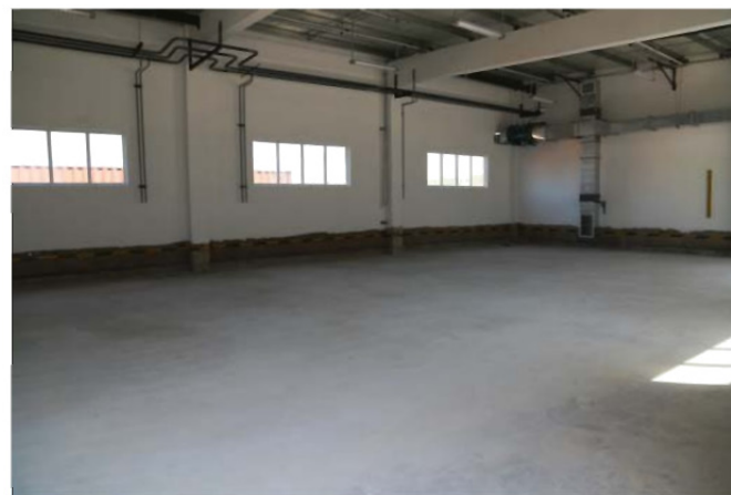
地面施工完成
