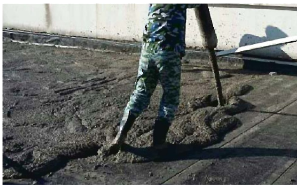
B型轻质垫层屋面施工
