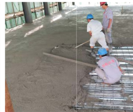
B型轻质垫层地面施工
