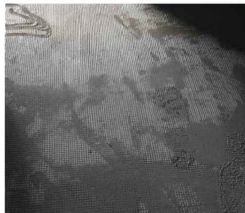
网格布铺后抹面
