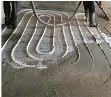
低温热水采暖垫层施工
