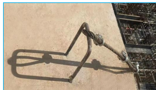
U型环连接方式示意图
