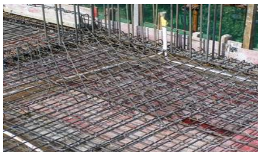
防裂构造钢筋
