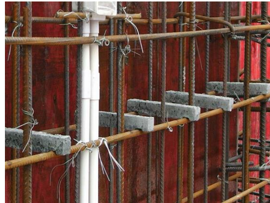
图 3.2-11 水泥砂浆支撑实例图
