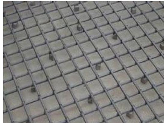
图 5.2-4 混凝土垫块
