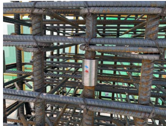
图 2.2-9 钢筋接头检查结果分色标识
