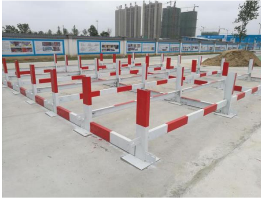
图 1.2-2 可周转钢筋支架现场实施照片 图 1.2-3 可周转钢筋支架节点图片
