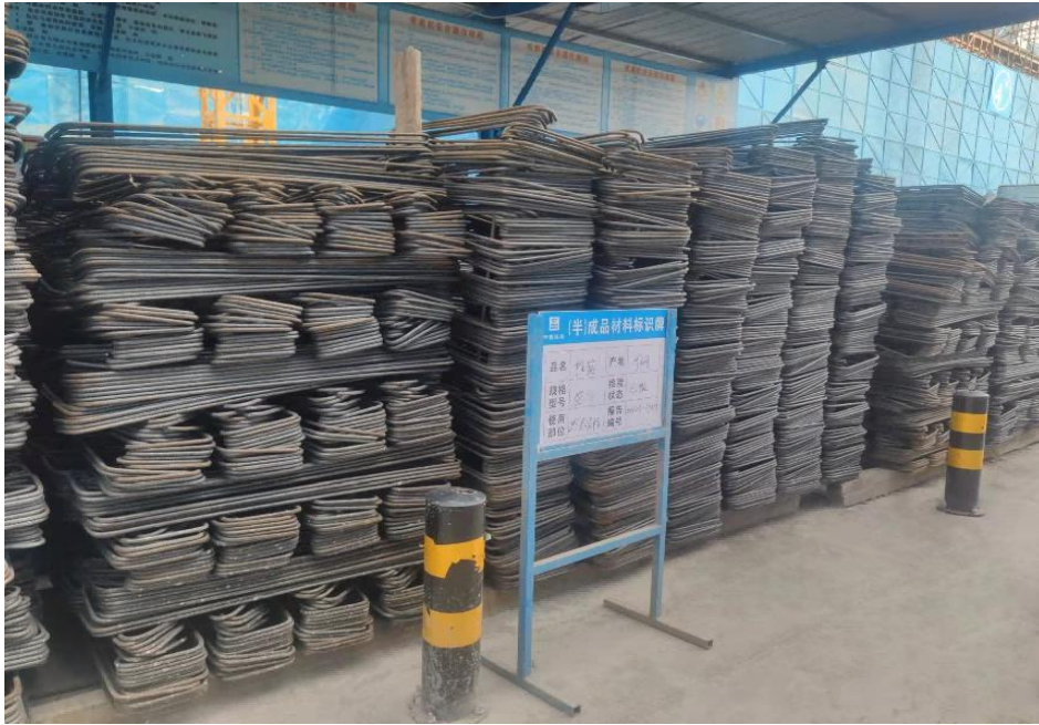
图 1.2-8 半成品钢筋堆放实例图
