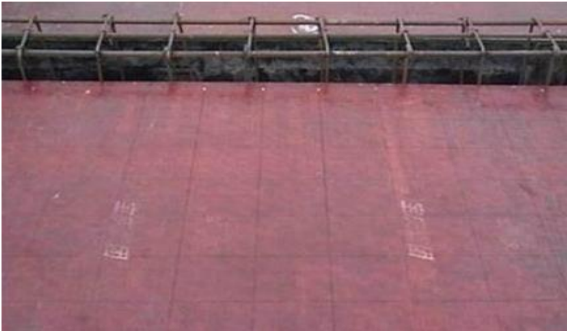
图 5.2-1 楼板钢筋绑扎前弹线实例图
