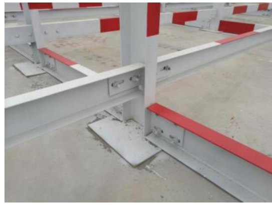
图 1.2-2 可周转钢筋支架现场实施照片 图 1.2-3 可周转钢筋支架节点图片
