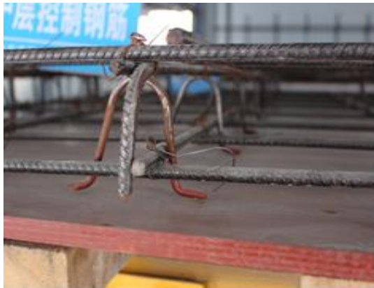
图 5.2-3 成品通长钢筋马镫（板厚 \leq 150\text{mm} ）
